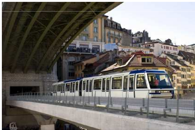
Investissements dans de nouvelles infrastructures Métro M2, Lausanne
