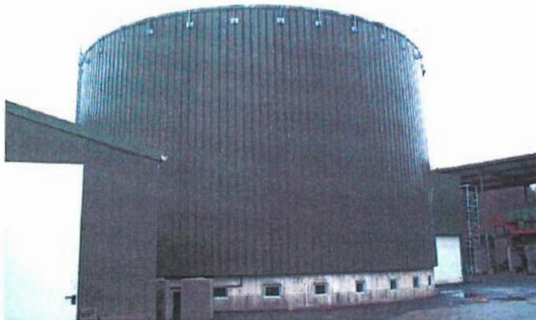
Photo N11 : digesteur de la biométhanisation
