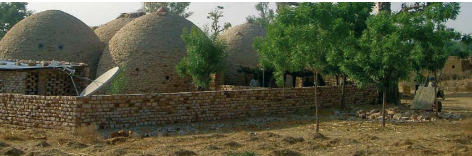
Hôpital rural de Dimmbal, un village du pays dogon au Mali où a été installée une antenne satellite permettant de suivre les enseignements à distance de médecine.
