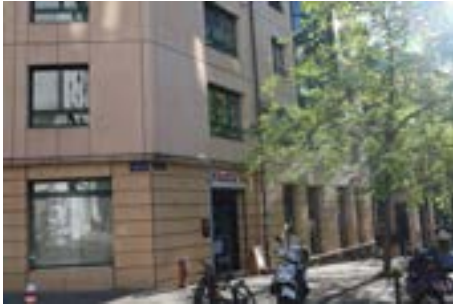
Le café Chez Joseph et, en dessus, l'appartement de Valentine, étaient situés à l'intersection de la rue des Sources et de la rue Micheli-du-Crest, à Genève. Le bâtiment a depuis été remplacé par un nouveau.
