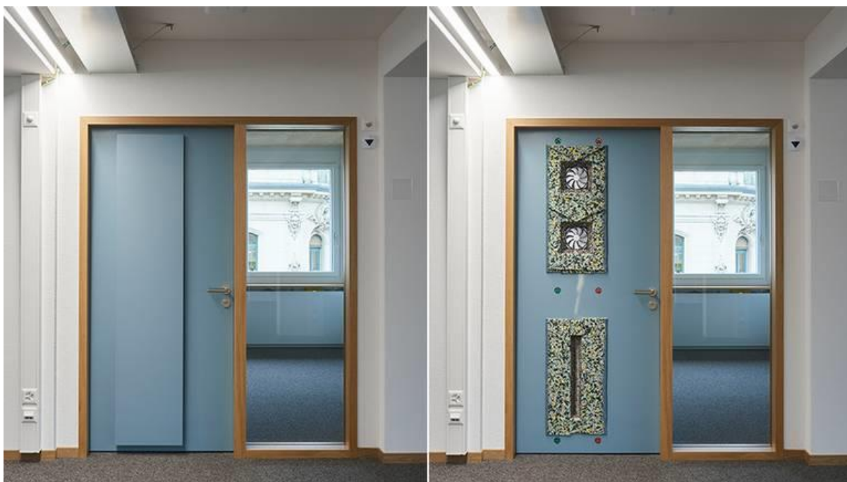
Des ventilateurs intégrés dans les portes, visibles sur la photo à droite sans cache, assurent la circulation de l'air entre les bureaux et le couloir. (Photo : Mettiss AG/Laura Egger)
