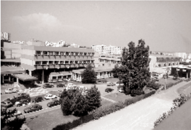
L'ENTPE avant les récents travaux d'extension. Au fond, le logement des étudiants.
