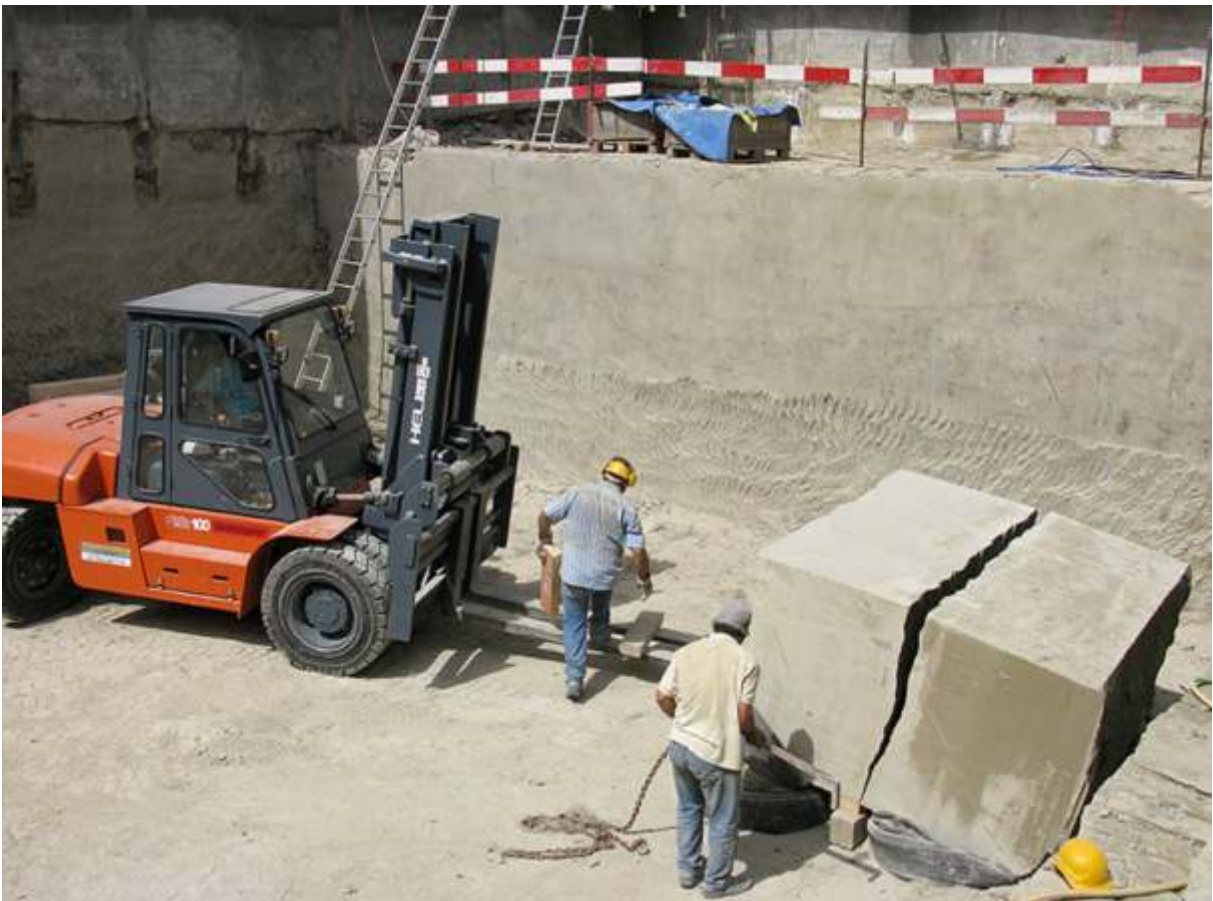
Extraction de la Molasse dans le jardin botanique de Genève en 2010. Photo Mello & Fils SA, Carouge.
