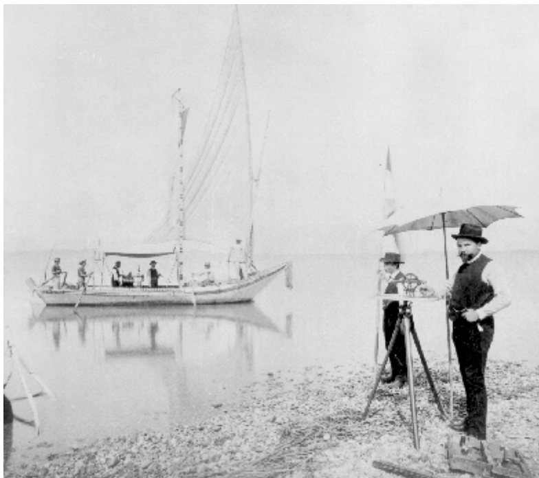
Méthode de mesure utilisée pour établir la carte bathymétrique du Léman (Forel 1892 ; Delebecque 1898). 1880-1890 (date indéterminée).
