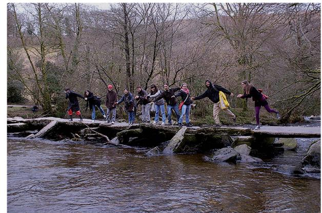
Le pont de Tarr Steps est construit avec des dalles de granite d'environ 5 tonnes chacune. Il fait 55 m de long et aurait été construit au 1er millénaire avant J.C.
