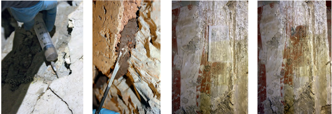
Fig. 4. Injections et pose de solins.
