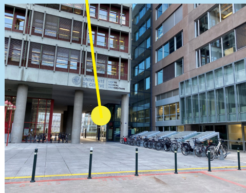
Entrée bâtiments A-B
