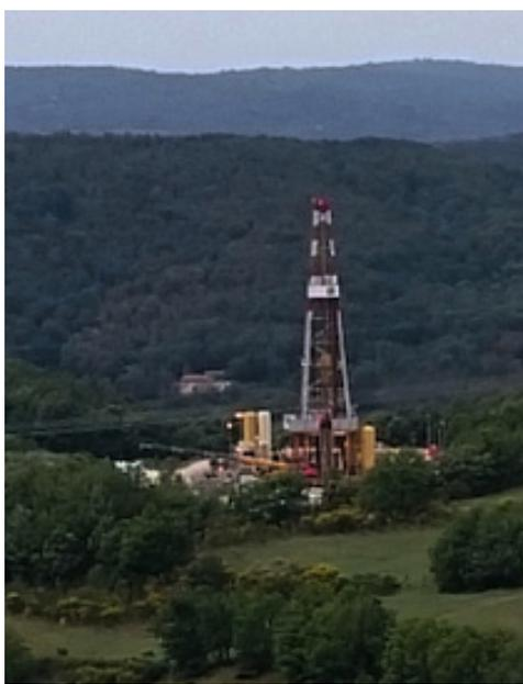
Vue du puits Venelle-2. Le puits a été conçu pour échantillonner des fluides supercritiques.
