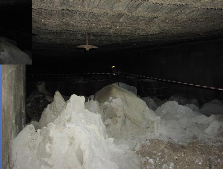
Stockamine, Alsace: effondrement d'une galerie de stockage de déchets chimiques
