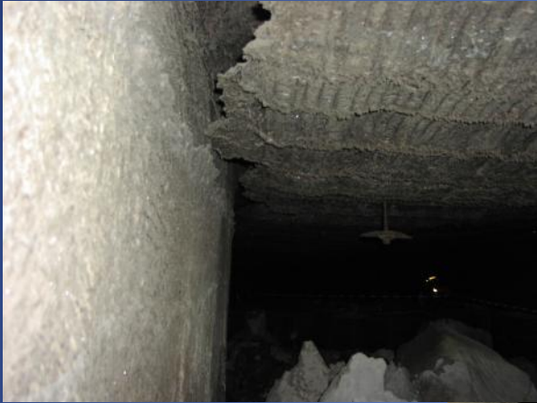
Stockamine, Alsace: effondrement d'une galerie de stockage de déchets chimiques
